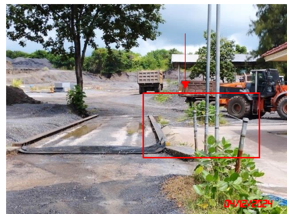
รูปที่ 33 จุดสเปรย์น้ำล้างล้อรถบรรทุก
