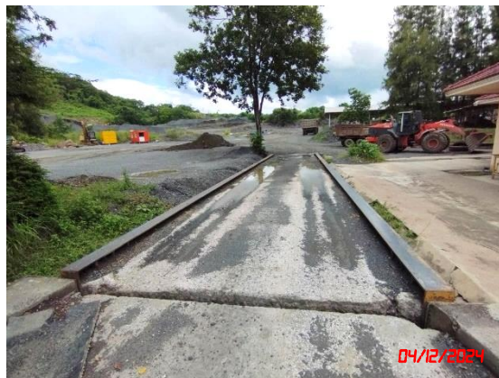
รูปที่ 33 จุดสเปรย์น้ำล้างล้อรถบรรทุก
